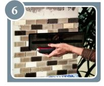
Aplanar uniformemente la placa recién aplicada con una llana de madera o caucho.
