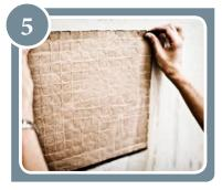
Aplicar las láminas de mosaico, con la cara de papel de frente a usted, presionando leve y uniformemente para eliminar los vacíos.
