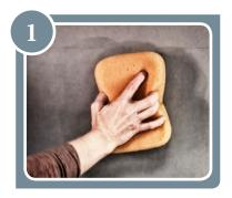
La superficie donde se instalará debe ser limpiada, remover toda basura o imperfección, ya sea por lijado o raspado y todos los huecos deben ser rellenados.
