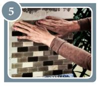
Aplicar\* las láminas de mosaico, con la malla hacia el material de instalación, presionando leve y uniformemente para eliminar los vacíos.
