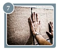
Aplicar\* cada lámina cuidando la secuencia y los espacios entre una y otra. Verificar el material de instalación antes de colocar la lamina. En caso de estar seco, retirarlo y aplicar de nuevo.
