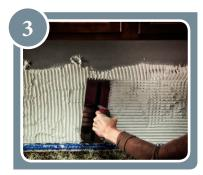
Aplicar una segunda capa de material, tomando a 45° una llana dentada, realiar surcos verticales y combinarlos después con surcos horizontales.
