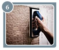
Aplanar uniformemente la placa recién aplicada con una llana de madera o caucho.
