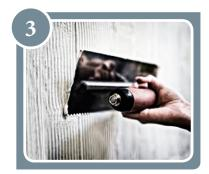
Aplicar una segunda capa de material, haciéndole surcos en una misma dirección con una llana dentada.
